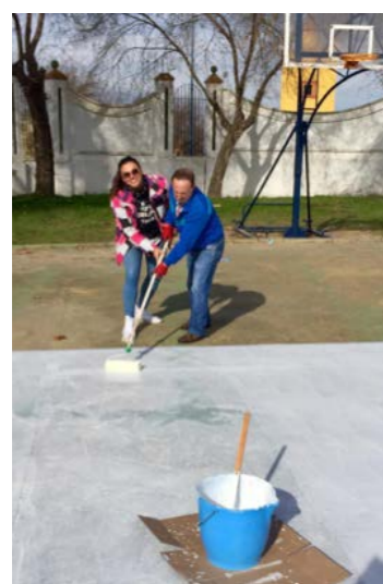
Preparación del suelo para diseñar la Criba en el patio del instituto.
